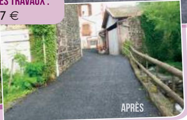
Les travaux du marché à bons de commande ont également permis de reprendre des chaussées dégradées, impasse de la Veyre et rue des Coteaux où le faïençage du revêtement menaçait à terme de générer des nids de poule.
