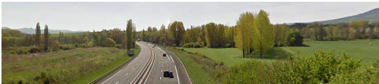
Les rivières de la Veyre et de la Monne et leurs ripisylves sont coupées par l'autoroute.
